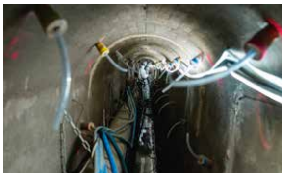
Réhabilitation de l'ovoïde Gustave Roch, Nantes
