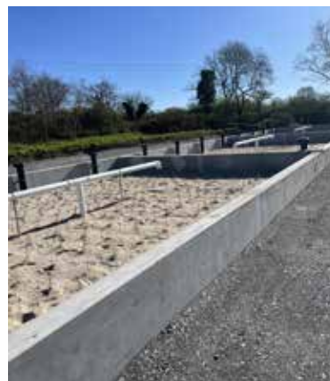
Construction filtre planté de roseaux STEU du Taillis, Les Sorinières
