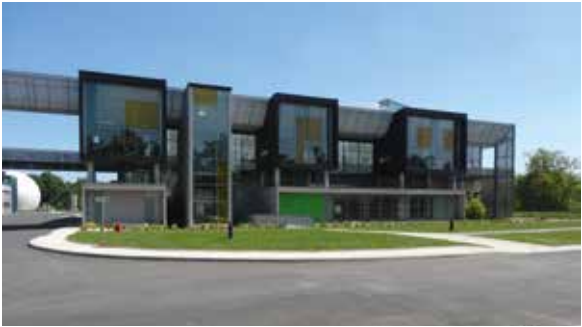
Station d'épuration Petite-Californie
