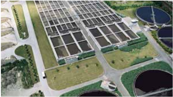
Station d'épuration de Tougas
