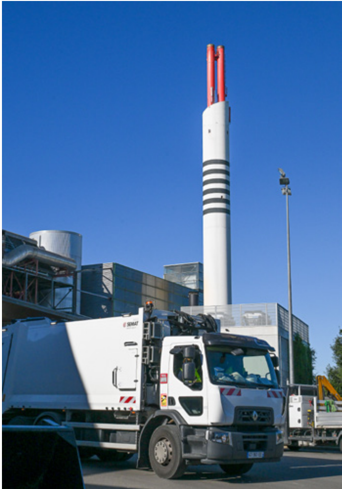
Cheminée de l'usine ARC EN CIEL 2034
