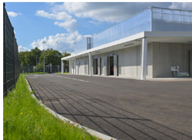
Locaux de la nouvelle déchèterie de La Montagne
