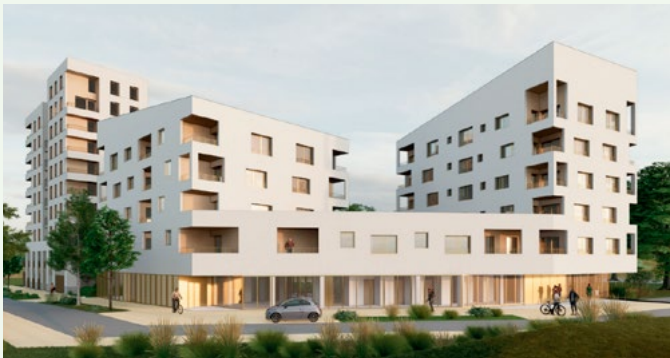
La future résidence autonomie et l'immeuble du Chêne Rouge en arrière plan © Mabire Reich
