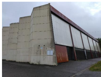
Bugallière Restructuration toiture, mise en accessibilité 1 M€
