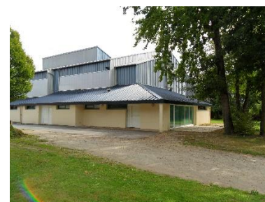
Bois Raguenet Construit en 1980 Travaux 2019 42 ans
