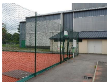
Bois Raguenet Rénovation sol des courts de tennis extérieurs ~0,1 M€
