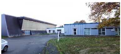
Cholière, gymnase Construit en 1971 Renfort charpente 2021 51 ans
