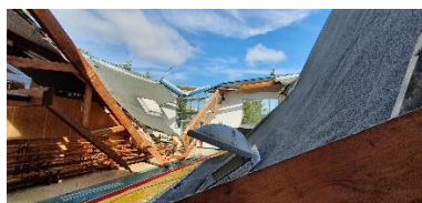
Cholière Reconstruction salle arts martiaux et restructuration vestiaires ~1,3 M€
