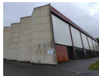
Bugallière Construit en 1976 Renfort charpente 2021 46 ans
