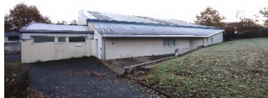
Cholière Démolition halle de tennis – courts 1 et 2 et club-house ~0,2 M€
