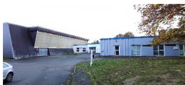
Cholière Tranche 2 : gymnase ~ 4M€
